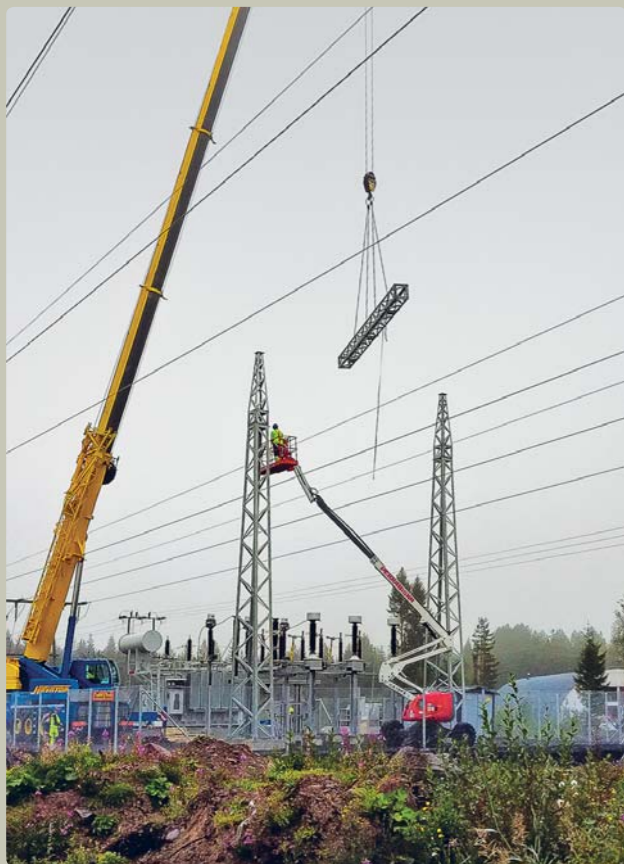
Lyft och montering av portal vid Ylivieska elstation. Portaalin nosto ja asennus Ylivieskan sähköasemalla.
