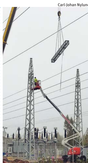
Ylivieska elstation har fått en ny portal och ny transformator.
