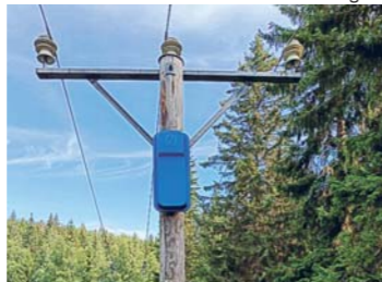
Safegrids felindikatorer kan monteras både på luftlinjer och jordkablarna.
