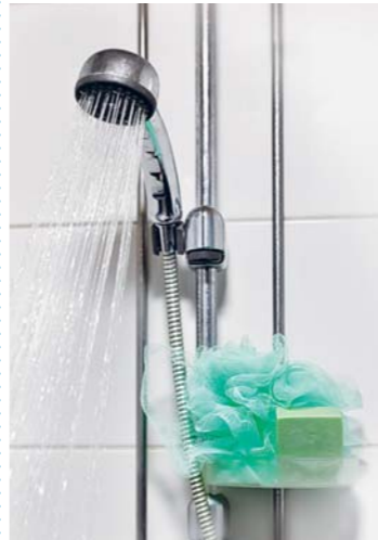
Ett effektivt sätt att spara energi är korta duschar.
