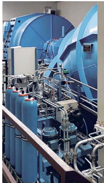
Vattenkraftverket vid Kattilakoski har renoverats och utrustats med ny teknik.
