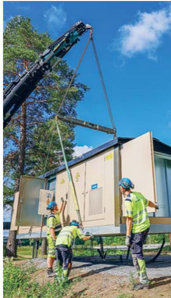
Esseborna har kunnat notera mycket grävarbeten under sommaren.
